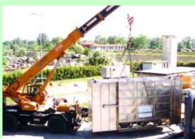
L'impianto di Depurazione di Seravezza dove è installato un Flottatore Lamellare con capacità di trattamento pari a 250.000 \text{ l/h} ,
