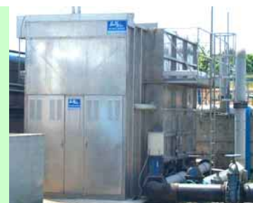
L'impianto di Depurazione di Seravezza dove è installato un Flottatore Lamellare con capacità di trattamento pari a 250.000 \text{ l/h} ,
