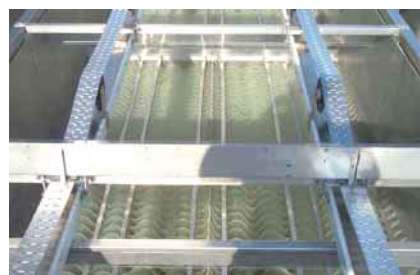
Pacco lamellare e convogliatore dei surnatanti
